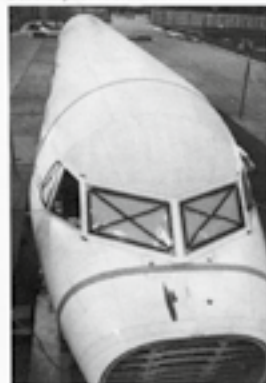
Der Rumpf der Fokker 100-001 nimmt in Schiphol Gestalt an
