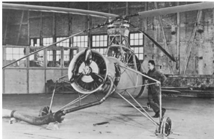
Der ineinander kämmende Doppelrotor – hier beim Versuchshubschrauber Fl 265 V1 – war ein typisches Konstruktionsmerkmal aller Hubschrauber-Konstruktionen von Anton Flettner.
