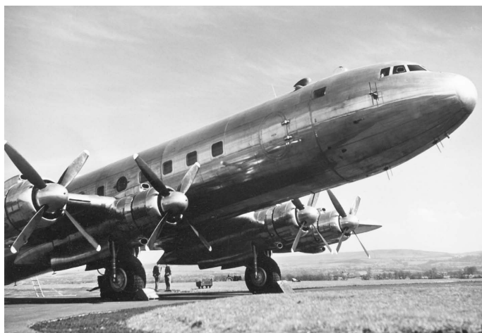
Die Tudor 7 mit Bristol Hercules Triebwerken erbrachte nicht die gewünschten Leistungssteigerungen.
