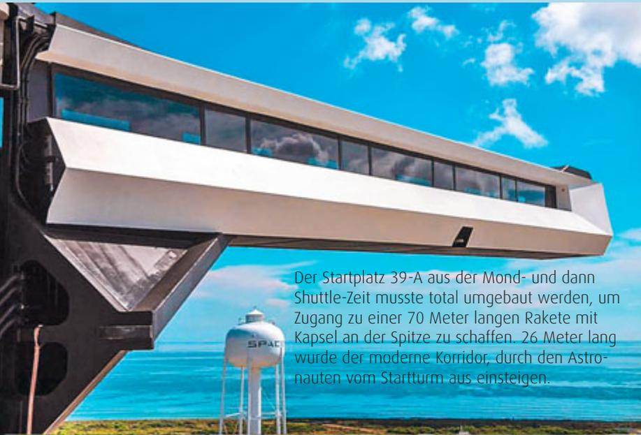
Der Startplatz 39-A aus der Mond- und dann Shuttle-Zeit musste total umgebaut werden, um Zugang zu einer 70 Meter langen Rakete mit Kapsel an der Spitze zu schaffen. 26 Meter lang wurde der moderne Korridor, durch den Astronauten vom Startturm aus einsteigen.
