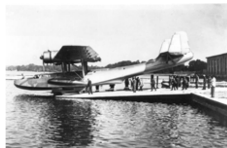
Erstmals Bodenseewasser unter dem Rumpf: Eine noch ohne Kennzeichen versehene Do 24 K-1 wird für einen Prüfflug zu Wasser gelassen.
