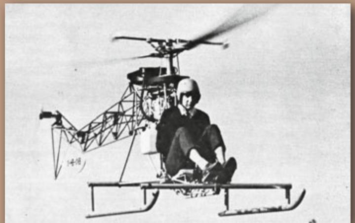
Eigenbaupionier Robert Stierlin baute verschiedene Helikopter, darunter den mit einem Johnson-Aussenbordmotor von 40 PS ausgerüsteten RS-40 X-HB-XVB, der heute im Verkehrshaus in Luzern ausgestellt ist.
