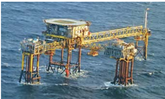
Oben: Shuttle-Stopp auf Halfdan B, während Regenschauer aufziehen. Unten: Dan B. Eine kleine Plattform, deren Helipad unterdessen wegen Korrosion geschlossen ist und die über einen Steg mit der Crossway Eagle verbunden ist.
