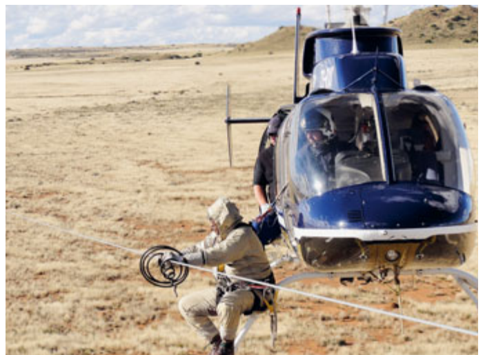
Die Wartung von Starkstromleitungen.
